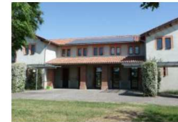
Centre de Loisirs Barricou - 9 kWc (Blagnac)
