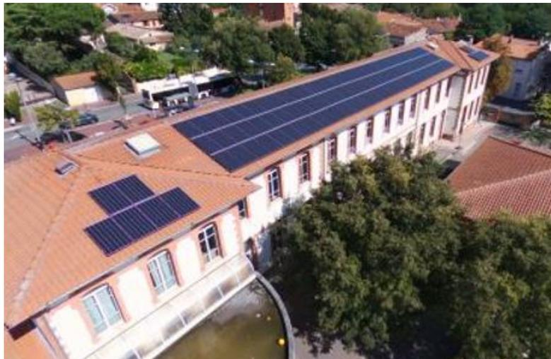
L'installation de 36 kWc (environ 200 m<sup>2</sup>) a pu donc se faire en surimposition de toiture.
