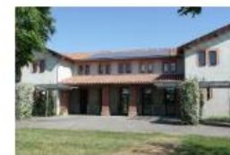
Centre de Loisirs Barricou - 9 kWc (Blagnac)
