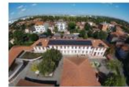
Groupe scolaire Littré - 36 kWc (Toulouse)
