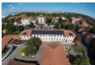
Groupe scolaire Littré - 36 kWc (Toulouse)
