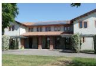
Centre de Loisirs Barricou - 9 kWc (Blagnac)
