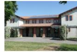
Centre de Loisirs Barricou - 9 kWc (Blagnac)
