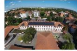
Groupe scolaire Littré - 36 kWc (Toulouse)
