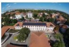
Groupe scolaire Littré - 36 kWc (Toulouse)
