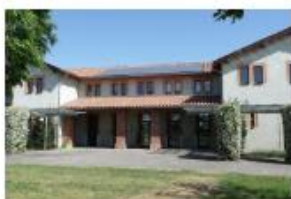
Centre de Loisirs Barricou - 9 kWc (Blagnac)
