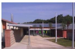
Centre de loisirs Cabirol - 100 kWc (Colomiers)
