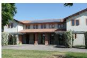
Centre de Loisirs Barricou - 9 kWc (Blagnac)
