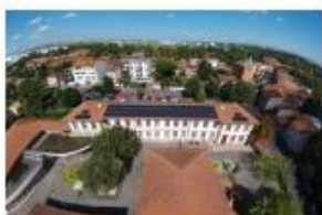
Groupe scolaire Littré - 36 kWc (Toulouse)
